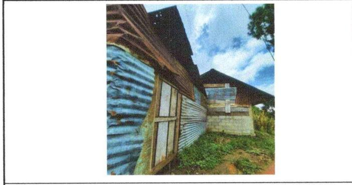
FOTO No. 5: Otra vista del techo que necesita ser cambiado por lámina troquelada.
